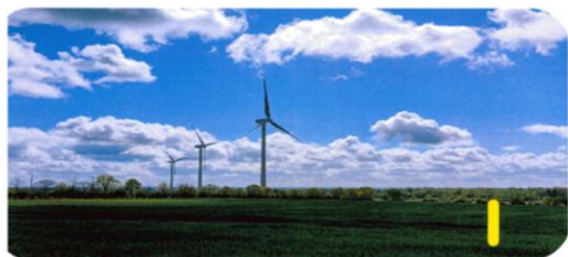
Photo du parc éolien de Saint-Barnabé actuellement en exploitation
